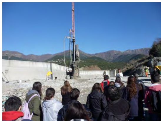
ΦΩΤ. 2. Κατασκευή εδαφοπασσάλου με Jet grouting με ειδικό μηχάνημα διάτρησης και διοχέτευσης ενέματος με πίεση 30 - 50 atm. εντός των χαλαρών υλικών μέχρι και ένα μέτρο μέσα στο βράχο (φλύσχος).
