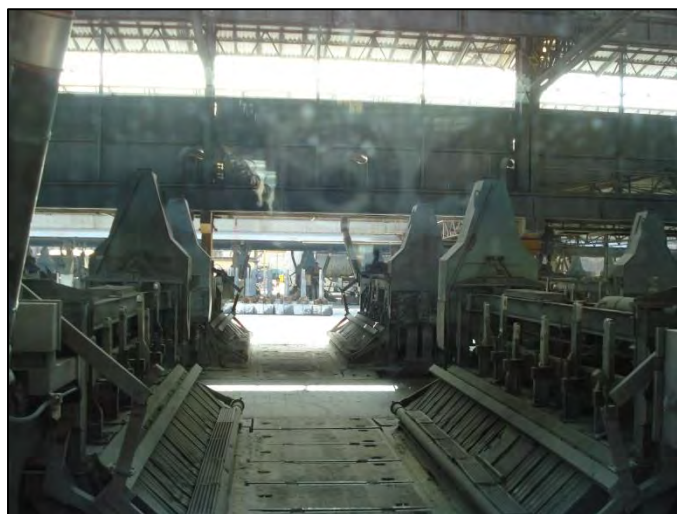
Εικόνα 9. Συστοιχία συσκευών ηλεκτρόλυσης.
