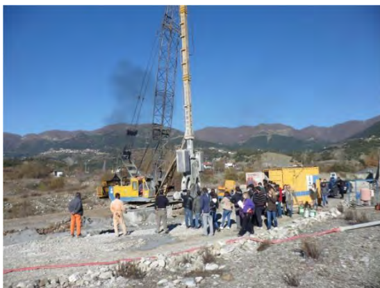
ΦΩΤ. 1. Κατασκευή αδιαπέρατου διαφράγματος κάτω από τον πυρήνα του φράγματος Μετσοβίτικου μέχρι το βραχώδες υπόβαθρο (φλύσχος) με ειδικό μηχάνημα (τύπου KELLY), που φέρει ειδικό σκαπτικό μηχανισμό (μπένα).
